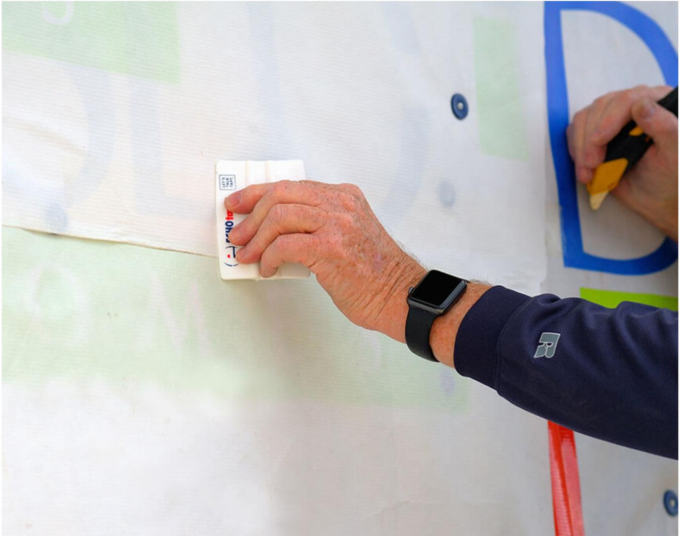
Pour ce qui est de la pression, M. Robinson recommande d'utiliser une raclette, un rouleau ou un rouleau en J en effectuant de longs mouvements réguliers. En exerçant une pression appropriée, l'adhésif agressif de la bande de soudure formera une liaison permanente avec la bâche dans les 72 heures.
